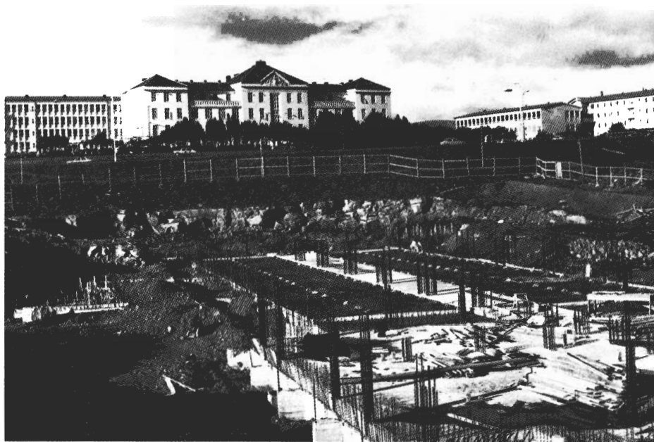
Framkvæmdir við byggingu húss Læknadeildar og Tannlæknadeildar í ágúst 1978.
