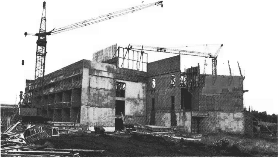
Oddi í byggingu, september 1982.
