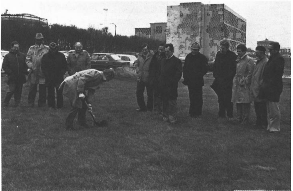
Guðmundur Magnússon háskólaþekkingarfræðingur tekur fyrstu skóflustungu að Odda 11. desember 1980. Bak við hann standa, frá vinstri: Haraldur Þorsteinsson eftirlitsmaður Framkvæmdadeildar Innkaupastofnunar ríkisins, Skúli Guðmundsson forstöðumaður Framkvæmdadeildar Innkaupastofnunar, Jóhann Þorkelsson húsvörður í háskólabýggingum, Guðmundur Halldórsson verkfræðingur, Daði Ágústsson verkfræðingur, Jóhannes Guðmundsson verkfræðingur, Ragnar Ingimarsson prófessor, Maggi Jónsson arkitekt hússins, Kristinn Ágúst Friðfinnsson stud. theol., og prófessorarnir Páll Skúlason, Sigurjón Björnsson og Sveinbjörn Björnsson.
