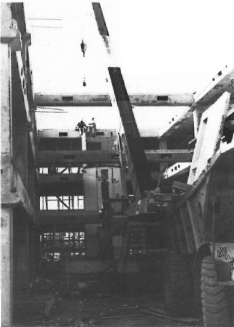
Tæknigarður í byggingu vorið 1988. Séð inn í miðbik hússins.
