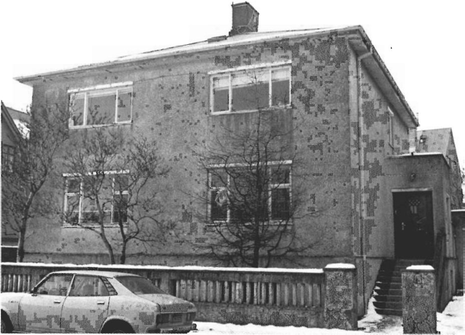
Húsið að Bjarkargötu 6 hefur verið í eigu Háskólans síðan 1969. Þar hafa lengi verið lesstofur viðskiptafræðinema, en jafnframt hafa nokkrir háskóla kennarar vinnuherbergi þar.
