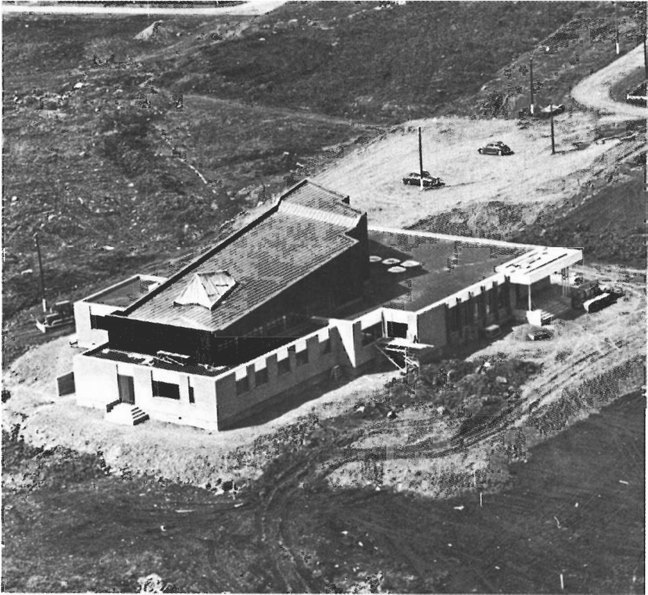
Norræna húsið í byggingu.
