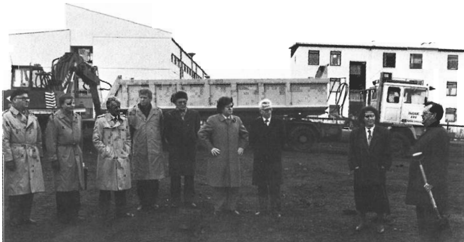
Fyrsta skóflustunga við Tæknigarð undirbúin á byggingarstaðnum 16. nóvember 1987. F. v.: Páll Sigurjónsson forstjóri Ístaks hf., Jóhann Malmquist prófessor og stjórnarformaður Reiknistofnunar Háskólans, Guðmundur Magnússon prófessor og stjórnarformaður Tæknipróunar hf., Jón Bragi Bjarnason prófessor og stjórnarformaður Raunvísindastofnunar Háskólans, Stefán Sörensson háskólaritari, Davíð Oddsson borgarstjóri, Sigmundur Guðbjarnason háskólarektor, Jóna Gróa Sigurðardóttir varastjórnarformaður Tæknigarðs hf. og Ragnar Ingimarsson prófessor og stjórnarformaður Tæknigarðs hf. Í baksýn eru stórvirk tæki frá Ístaki hf., sem bíða framkvæmdanna.
