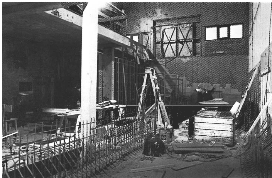
VR III í byggingu.
