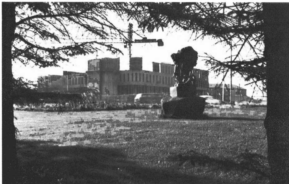
Þjóðarbókhláða í byggingu.
