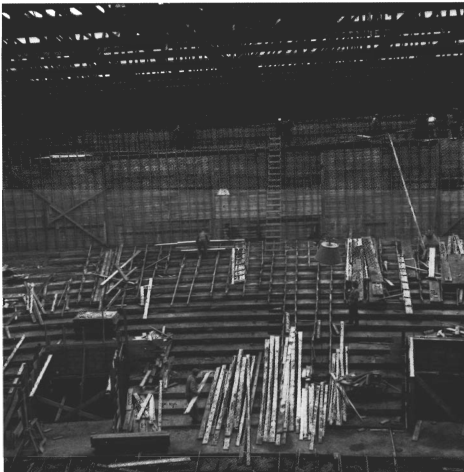
Unnið við byggingu Háskólabíós.
